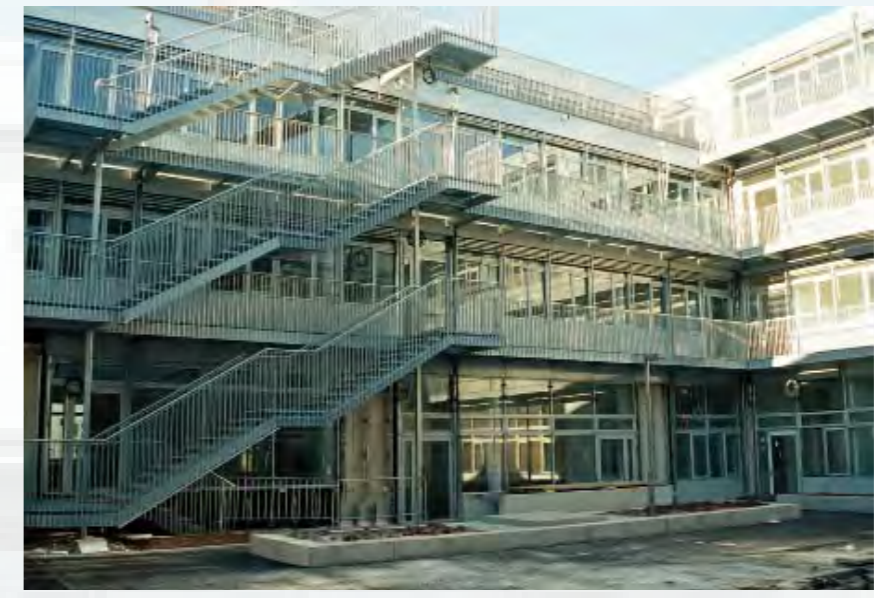
Fluchtbalkone und Fluchttreppen
